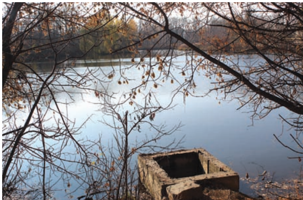
Труба біля дороги старої Водокачки
