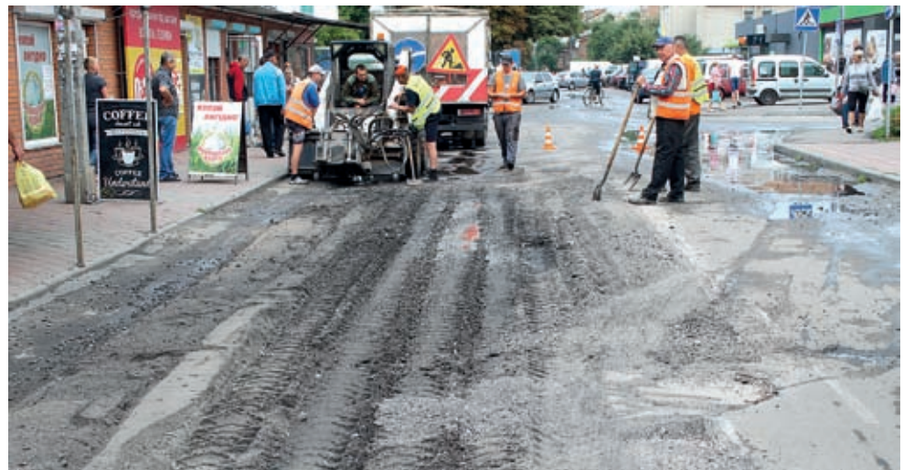
Ремонт вулиці Грушевського перед велопробігом на День Незалежності
