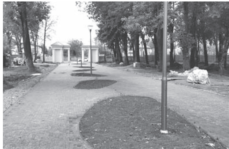
Загальний кошторис реконструкції — 20 млн грн. В парку викладають плитку, встановили ліхтарі та відновили арку
