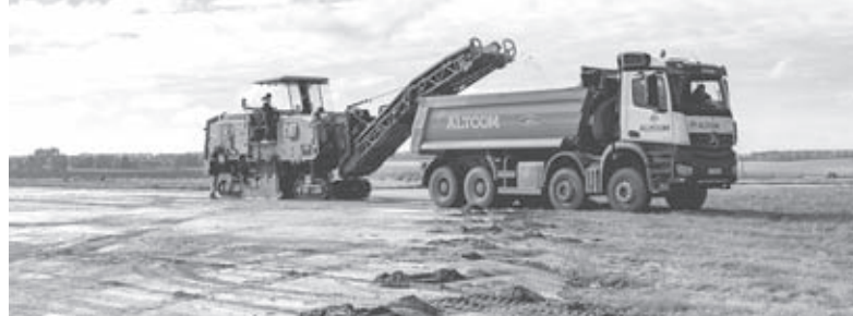
Щоб укріпити злітно-посадкову смугу, її треба частково зруйнувати. Робітники фірми-підрядника «Альтком» зрізають два сантиметри товщини існуючої злітки
