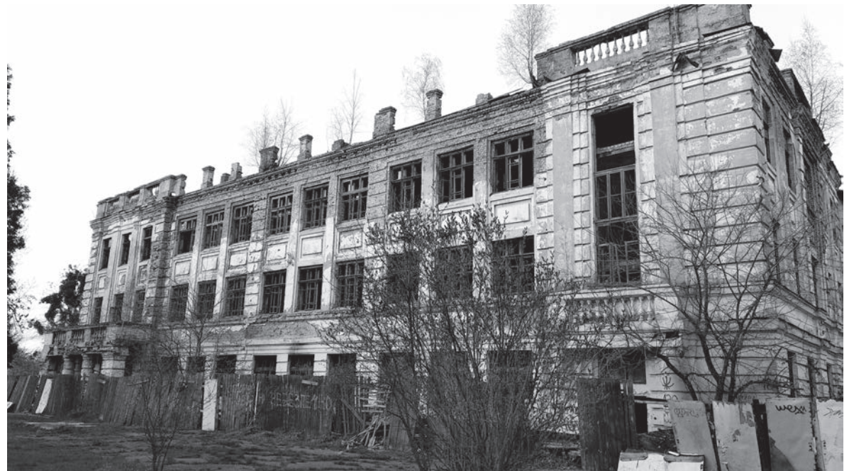
Стара будівля Житомирського міського колегіуму №34. Школа була побудована ще в довоєнні роки. Аварійний корпус міського колегіуму стоїть закритим з 1995-го року. Цю будівлю у вересні 2020 року було вирішено знести. Туалетів навіть для молодших класів тут не було навіть запроєктовано. Діти ходили в туалет на вулицю.
