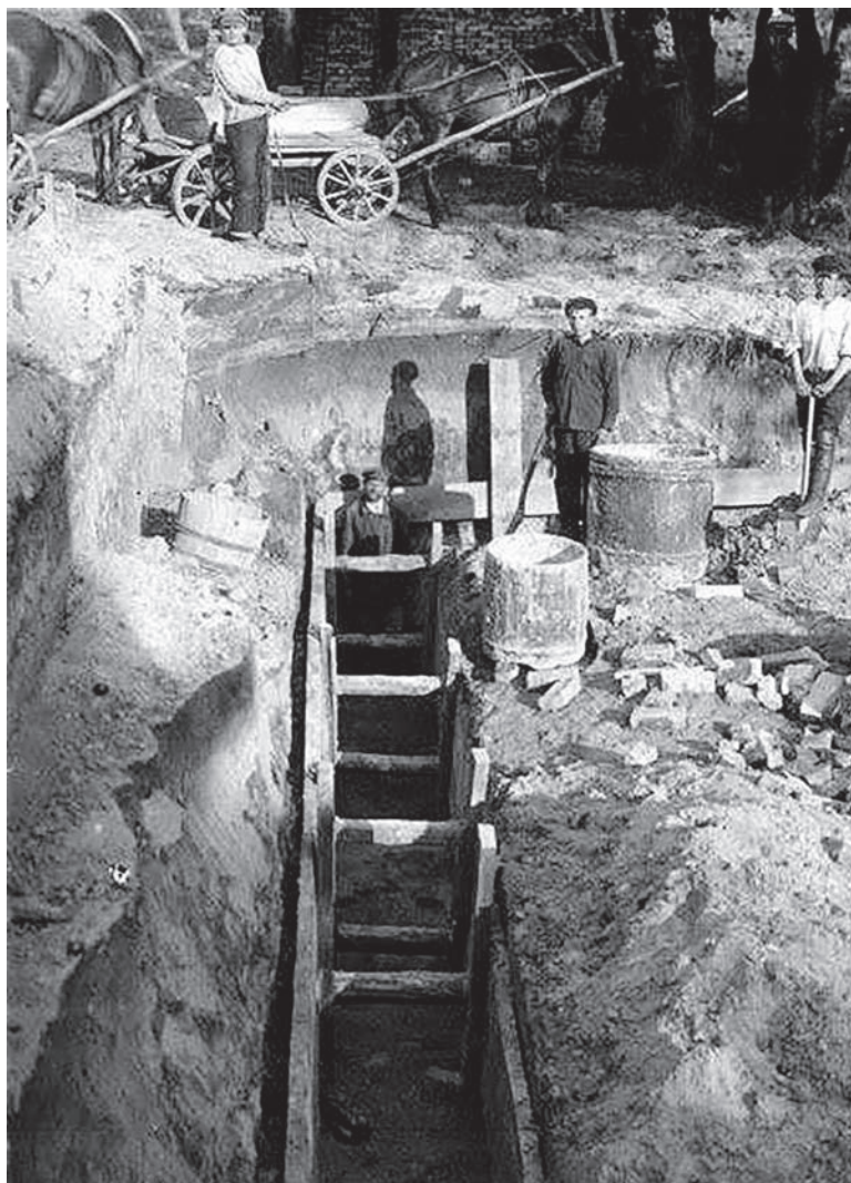
Закладка насосної станції на полях зрошення київської каналізації. Аналогічний вигляд мало будівництво першої каналізації у Житомирі.
