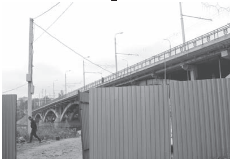
Підрядник доробить те, що не зробив попередній виконавець робіт. На завершення реконструкції мосту витратять 9,4 млн грн
