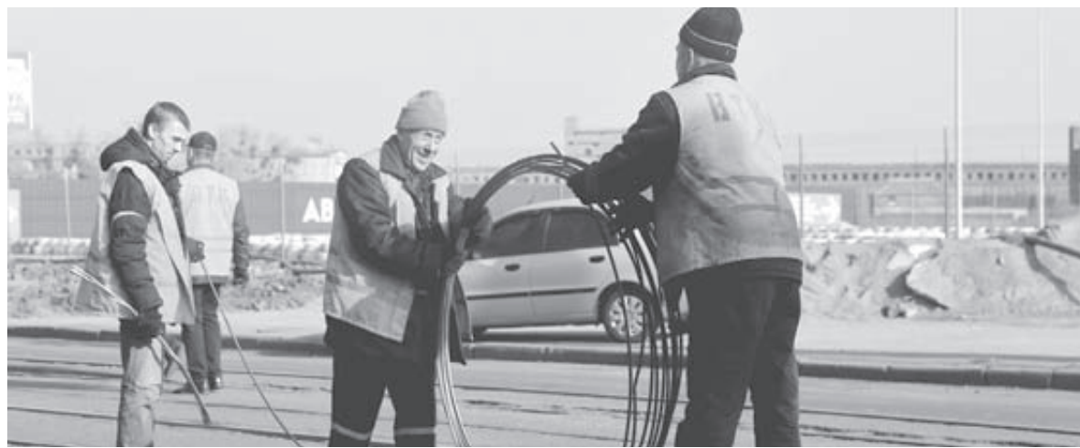
З першого дня у зоні реконструкції працює близько півсотні людей і двох десятків одиниць спецтехніки. Працівники на навісному обладнанні вже знімають старі контактні мережі, будуть замінювати їх новими
