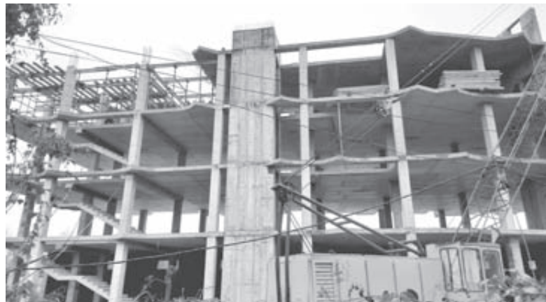
Зараз вже готова «коробка» будівлі. Спорудження готелю почалося ще цього літа
