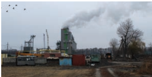
Це елеватор, на який скаржаться мешканці вулиці Пролетарської
