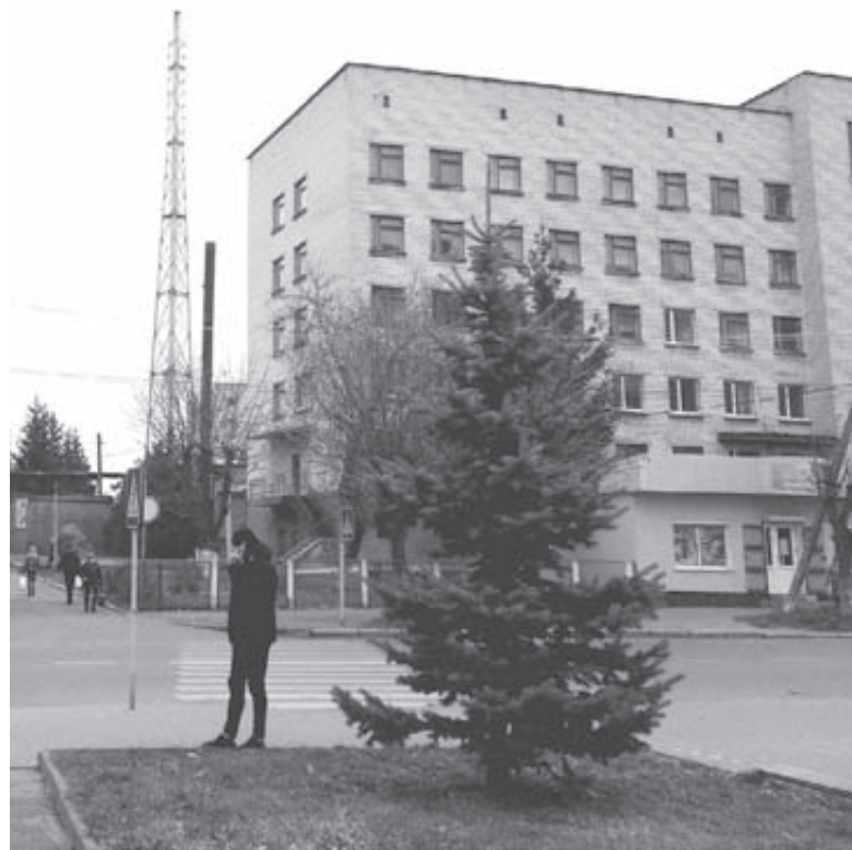
Нове обладнання закуплять, зокрема, для котельні №9, що на території колишньої залізничної лікарні. Загальна вартість проекту по ній — 3,3 мільйона гривень
