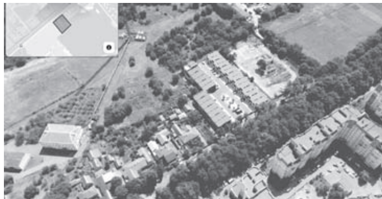
Ділянка, де будуватимуть домівки, зачищена. На старих знімках тут можна було розгледіти автостоянку і СТО
