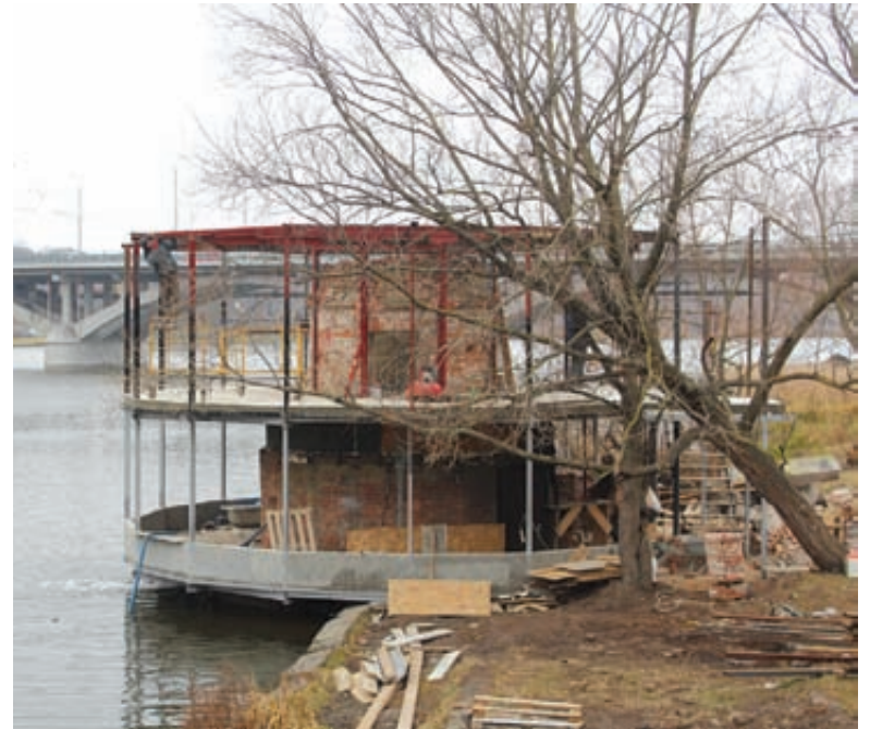
Ця цегляна башта — колодязь для першого міського водогону. На півострові була насосна станція з рядом споруд, але їх немає у реєстрах пам'яток архітектури
