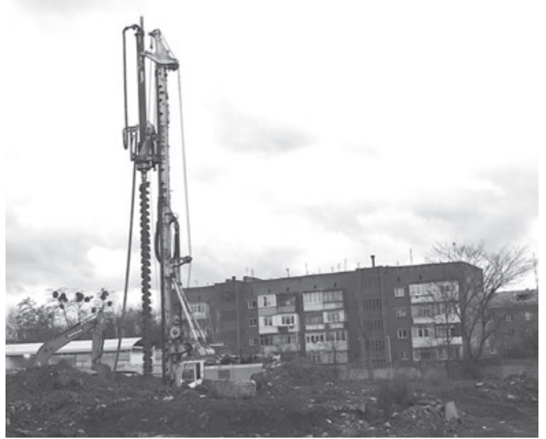
Спецтехніка вже працює на місці майбутнього мікрорайону. Але до будівництва черга ще не дійшла
