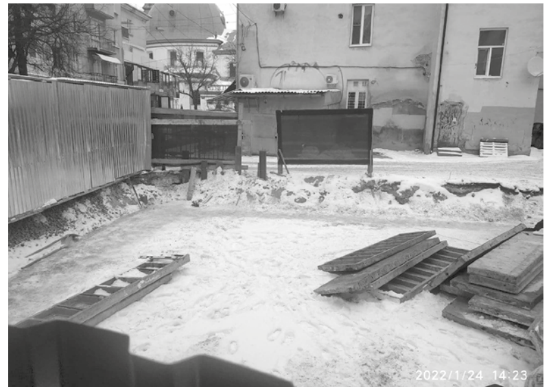
Навколо будівництва розташовані будівлі-пам'ятки місцевого значення. Архітектор каже, це їм не шкодить
