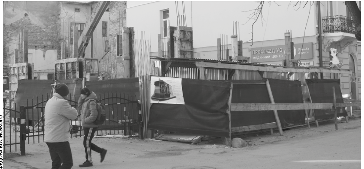
Працівники вже зводять стіни майбутнього готелю. Поруч є вивіска з планом будівництва
