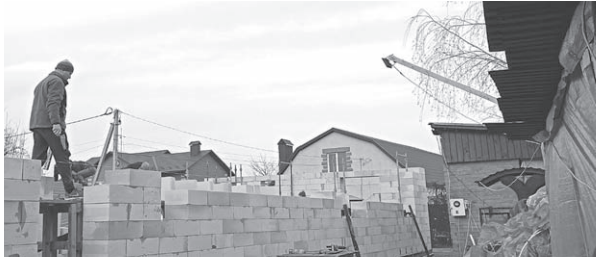
Згорілий будинок Кучеруків відбудовують заново. Дехто з будівельників готовий почекати з розрахунком до того часу, коли постраждалі матимуть гроші
