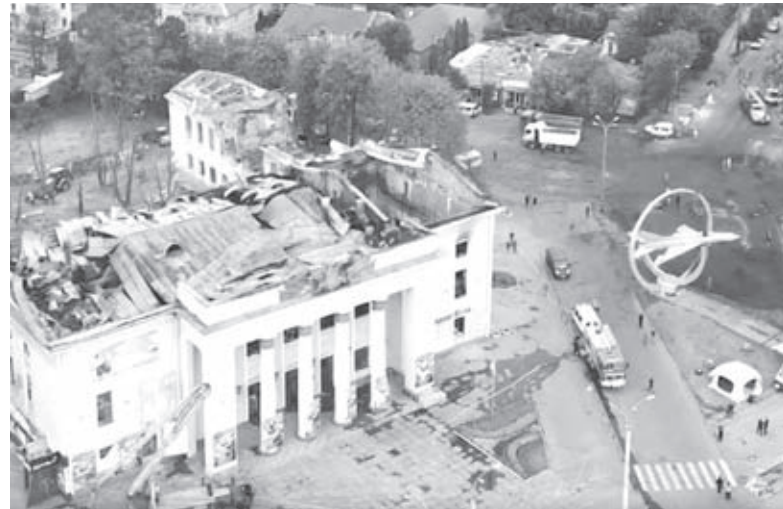
Фасад будівлі з колонами вцілів. Але далі будівля зазнала значних пошкоджень
