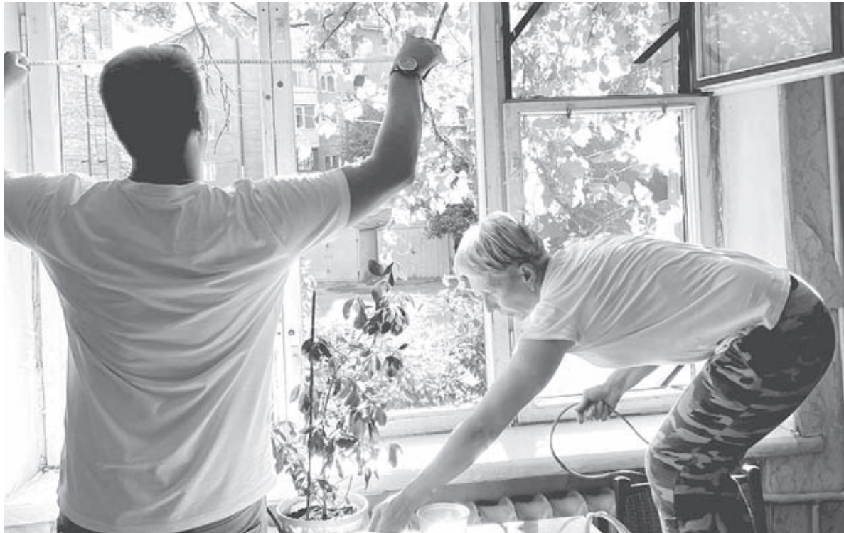
Волонтери допомагають вінничанці заклеювати вікна. Від ракетного обстрілу постраждало понад п'ятдесят будинків
