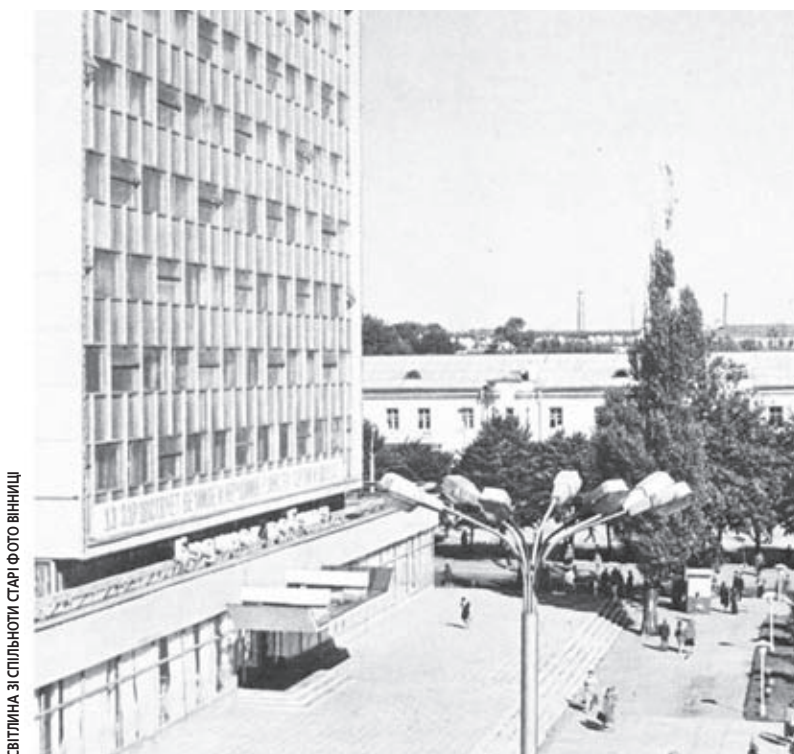
Такий вигляд мав будинок побуту «Ювілейний» у 1982 році. Зараз будівля зруйнована внаслідок ракетного обстрілу
