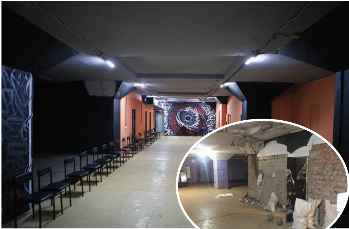
Такою стала після ремонту одна із кімнат укриття на «Кристалі». У сховищі є також імпровізована їдальня, вбиральні, душ, місця для сну
