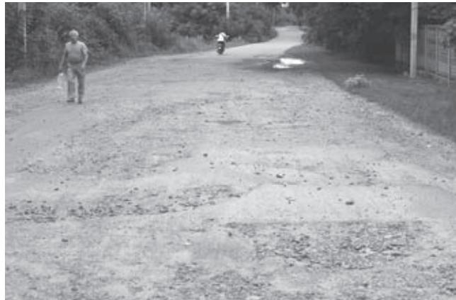
Вулиця Центральна. Найглибші ями дорожники чомусь оминули і з ремонтом дороги далі пішли
