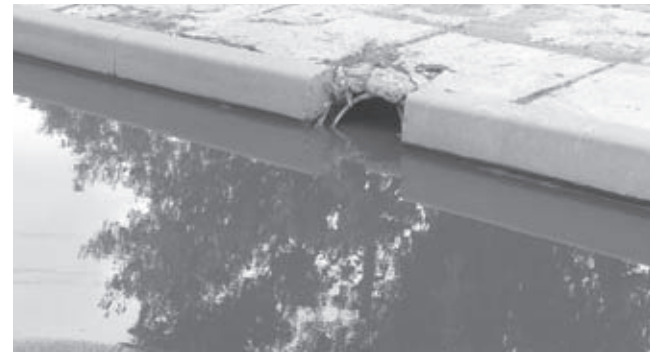
Щось пішло не так. Водовідведення на вулиці Довженка
