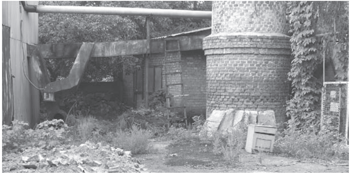
Сліди ремонту котельні є. Але чомусь настала в роботі велика пауза
