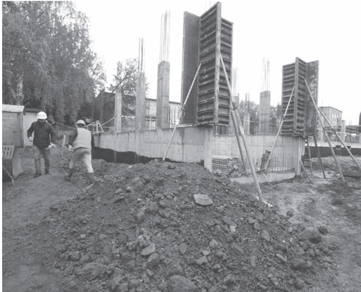
Триває зведення каркасного будинку. Опалення, підігрів води, пічки — усе в цій багатоповерхівці буде на електриці
