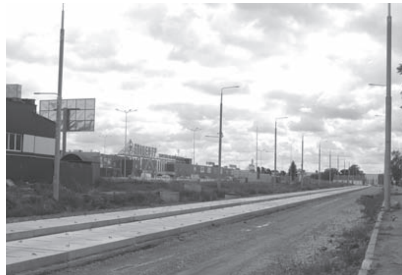
Колію на Батозькій будуватимуть за технологією «оксамитовий шлях». Завдяки мінімальній кількості стиків між рейками, трамвай їздить швидко і тихо
