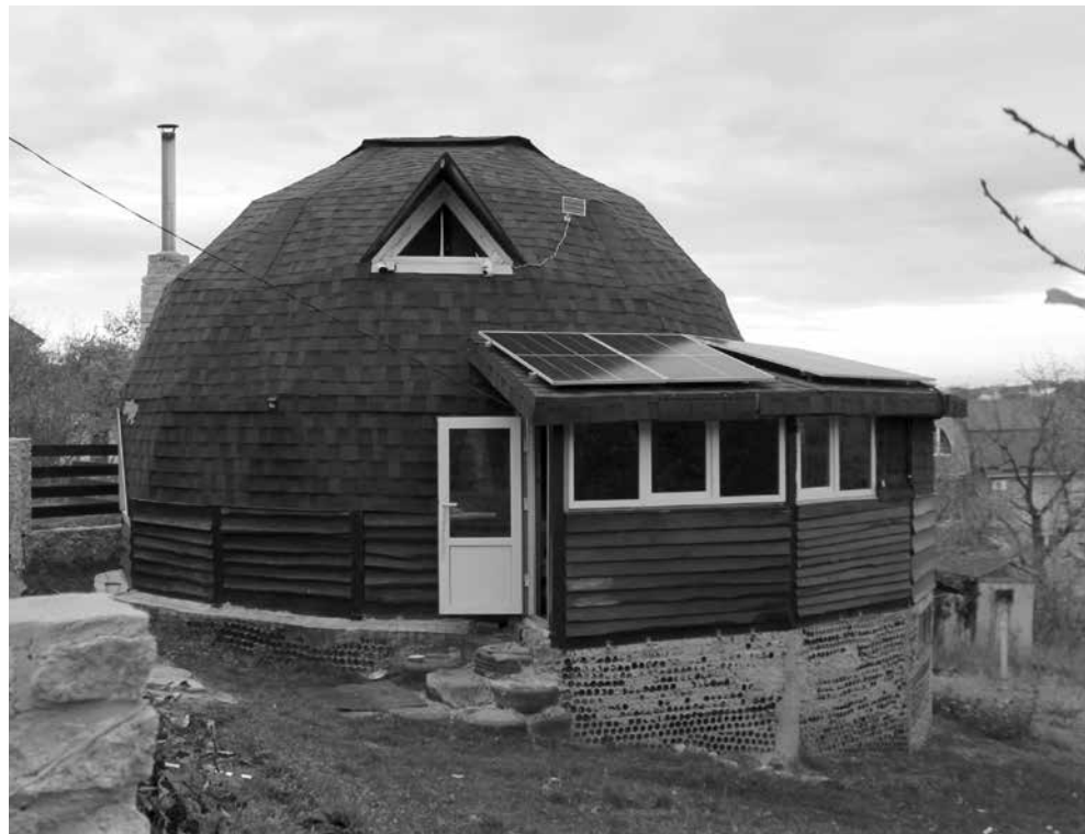
На даху встановлені сонячні батареї, завдяки яким завжди є світло і гаряча вода
