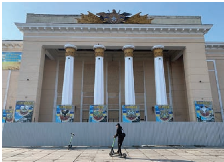
Такий вигляд зараз має фасад Будинку офіцерів. У ньому заколотили всі вікна, щоб будівля не зіпсувалася ще більше за час зими
