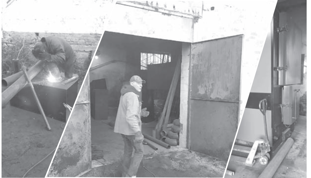
У шостій котельні, яка опалює Козятинський ліцей та перший садочок, встановлюють нове обладнання. На питання до робітників, коли подадуть тепло, відповіли — як тільки, так відразу
