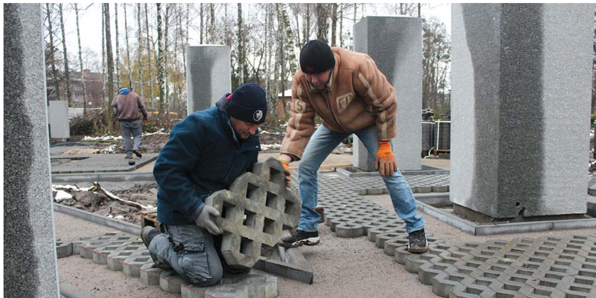
Робітники укладають плитку між колонами. Гранітних стовпів тут 48 і кожен із них важить по шість тонн
