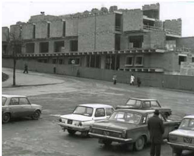
Триває будівництво краєзнавчого музею у Тернополі, 1980-і рр.
