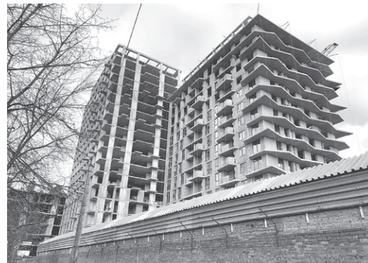
Будівництво наразі найвищого у Вінниці будинку (ліворуч). А такий буде мати вигляд ця багатоповерхівка після закінчення будівництва (праворуч)
