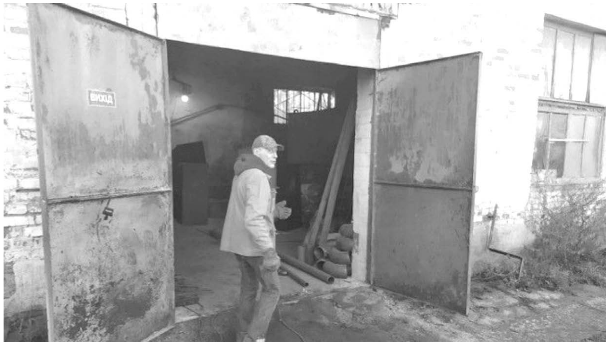
Торік на котельнях встановили нове обладнання. Але зберігати температурний режим вдається не скрізь, найхолодніше — в опорному ліцеї та першому садочку
