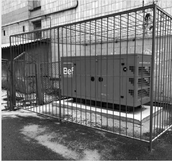
У школі №16 уже встановили та під'єднали генератор. Його потужність сягає 60кВт
