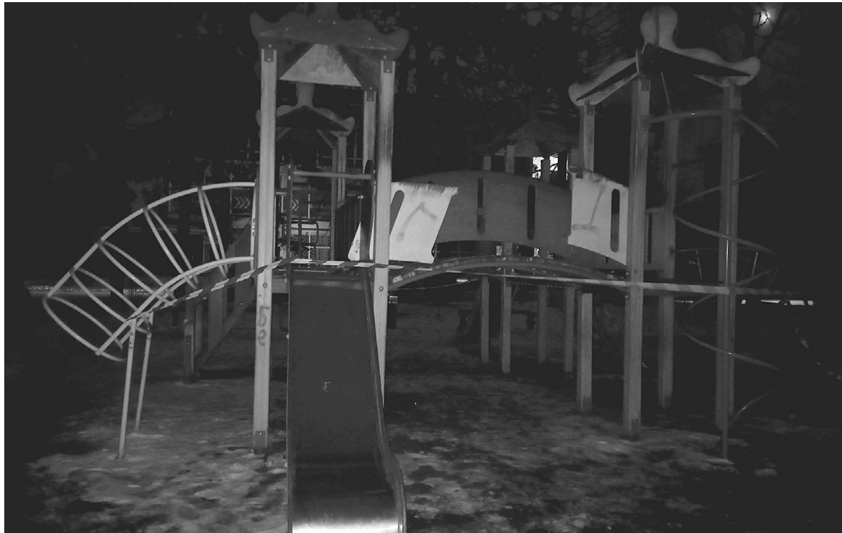
Такий вигляд тепер має гірка на майданчику. Опору виламали не лише в цьому місці
