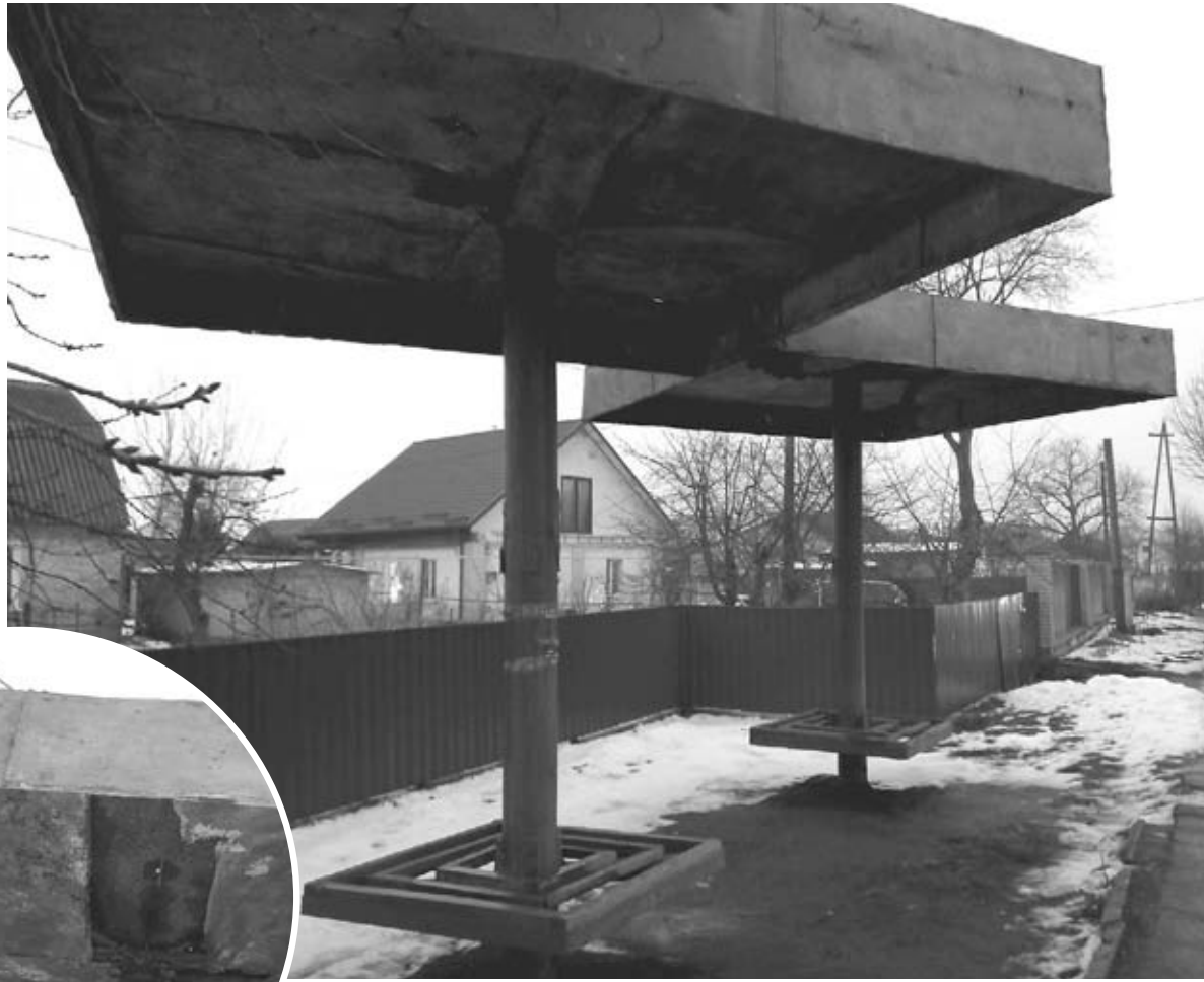
Зупинка неподалік від перехрестя із Білоцерківською трасою. Металеві листки під дахом поїла корозія
