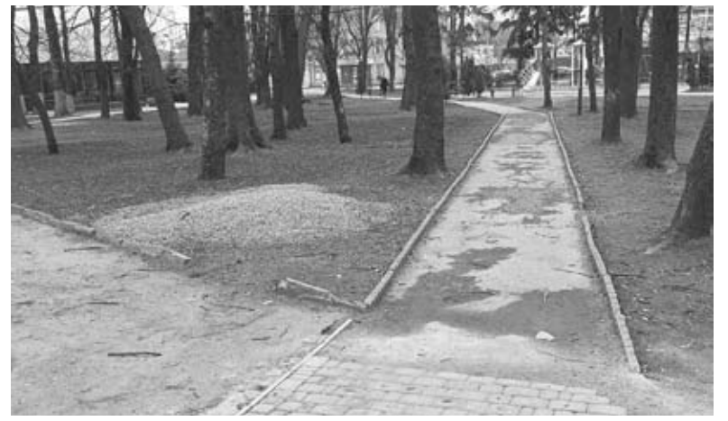
Роботи по ремонту доріжок у парку розпочалися в листопаді 2022 року. Вже березень 2023. Наразі тут робота «не кипить»
