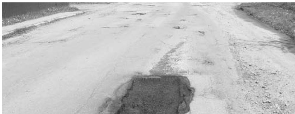
Ямковий ремонт на вулиці Героїв Майдану. Тут пора робити вже капітальний ремонт
