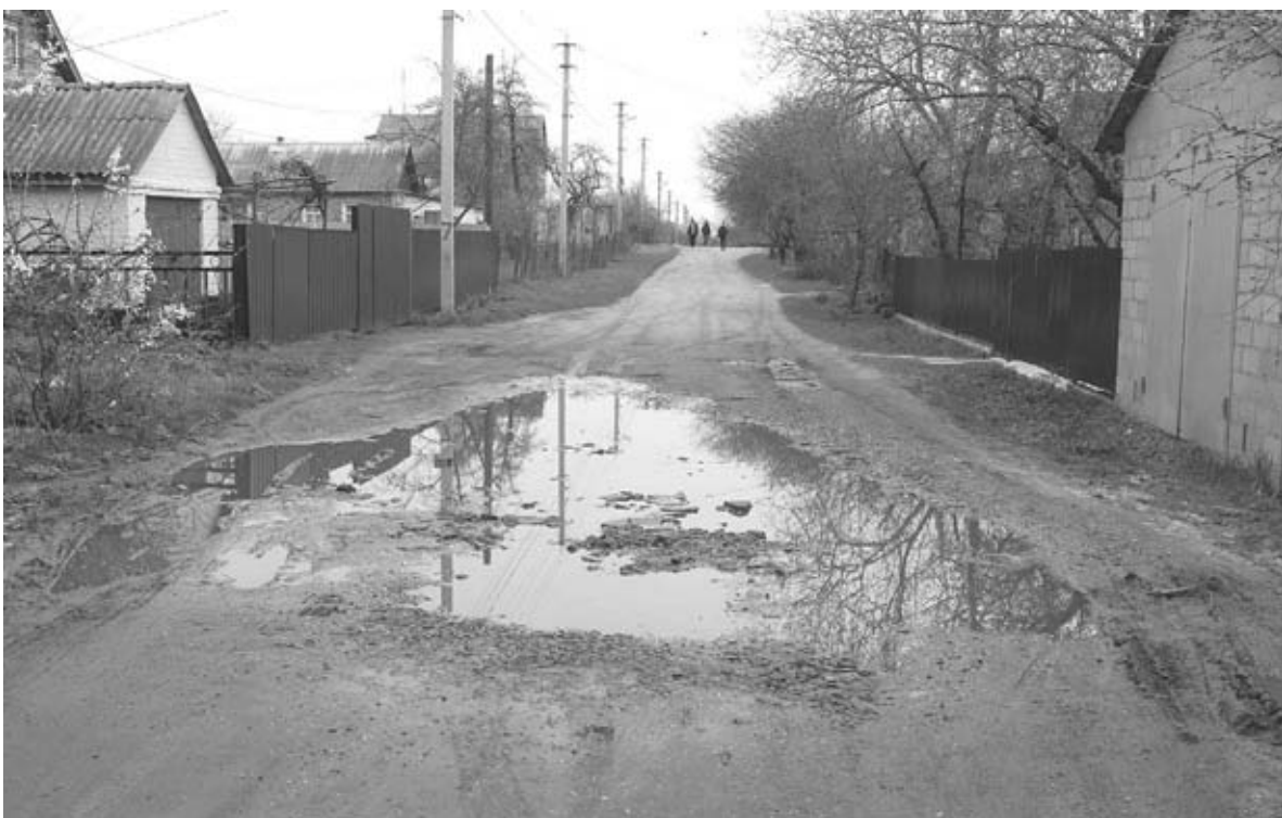
Опадів не було вже три дні, а калюжа досі не висохла. Можна тільки уявити, як вулицею Горіховою ходять люди під час дощу
