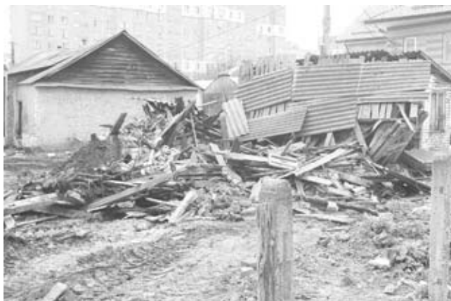
Демонтаж розвалюхи в центрі міста. Її давно вже було пора знести, щоб не псувала вид міста
