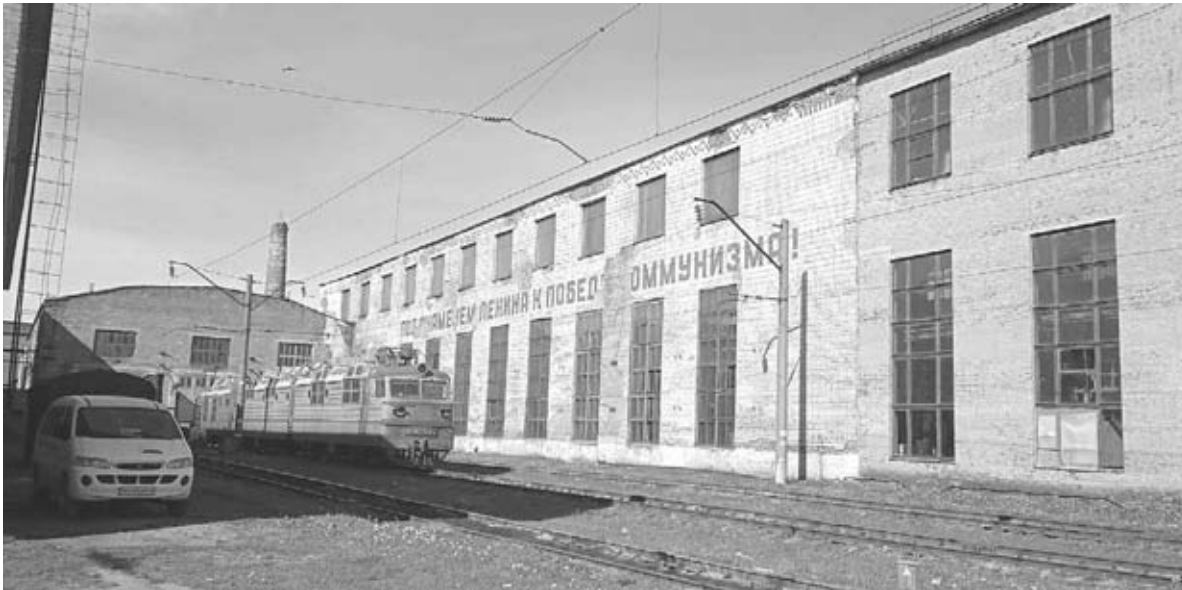
Будівля ТР-3 локомотивного депо. Зеленою плиткою викладена комуністична фраза
