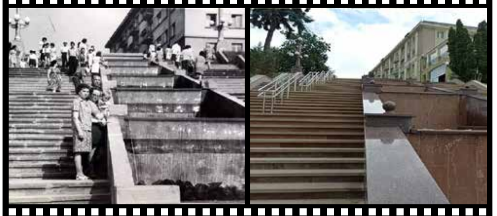
БУЛО: Фонтан на вході до парку Шевченка запрацював у 1972 році СТАЛО: Його відремонтували, додали різнокольорову підсвітку
