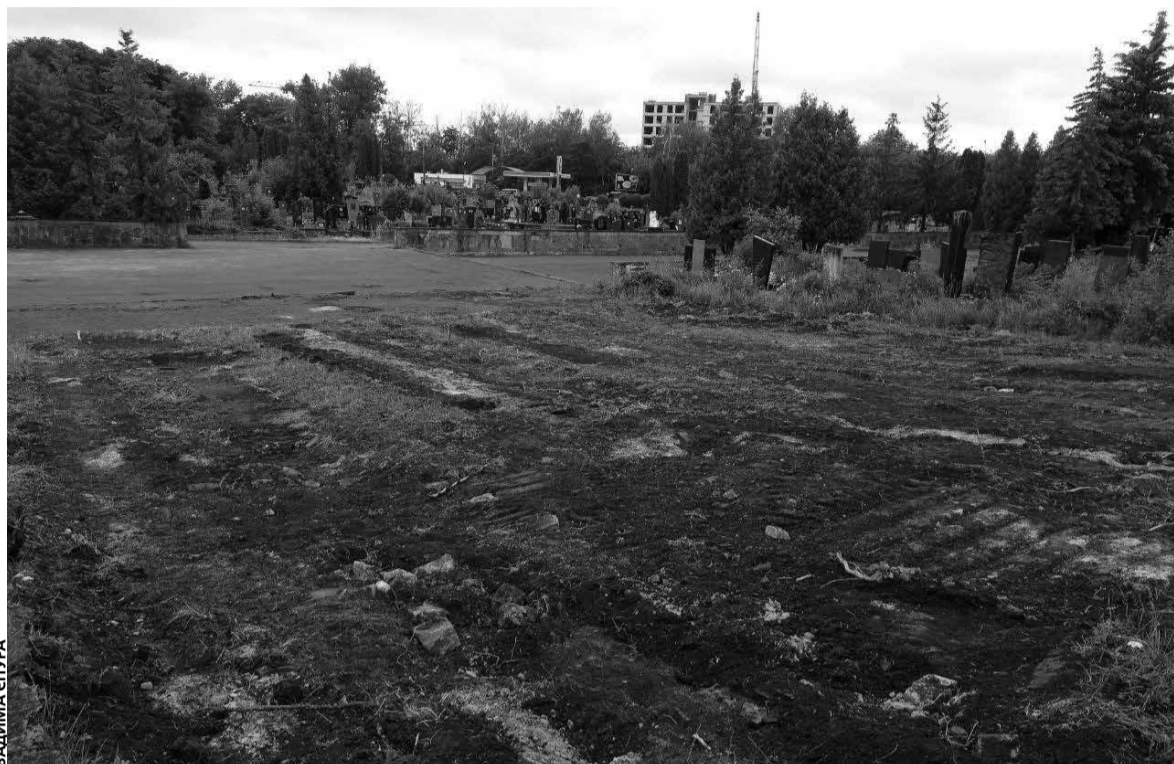
Частину плит демонтували, а дерева зрізали
