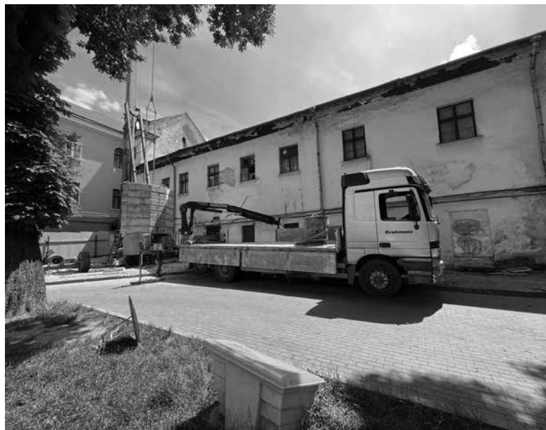
6 липня на територію заїхала перша будівельна техніка
