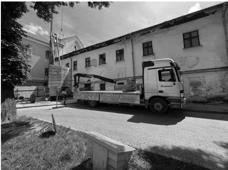
Шостого липня на територію комплексу заїхала перша будівельна техніка
