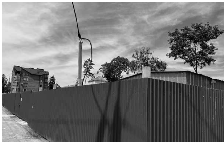
Вздвож проспекту бачимо довжелезний паркан. Ось тут, власне, і виростає чергова багатоповерхівка в Тернополі
