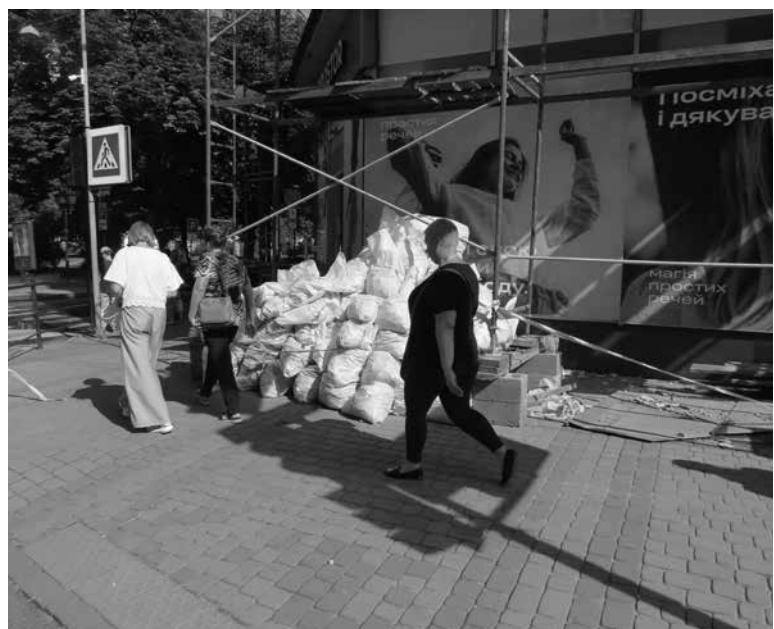
Поруч лежать мішки та будівельні матеріали
