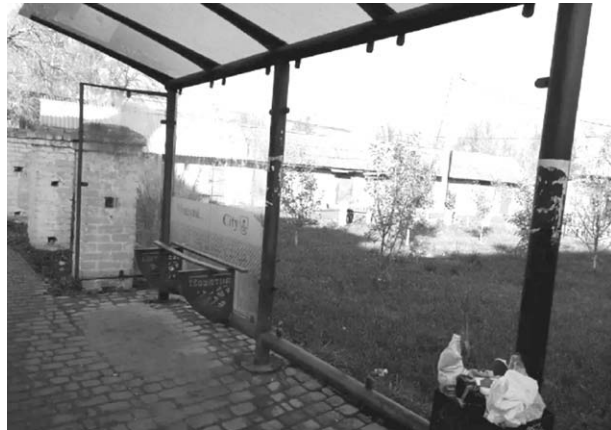
Такий вигляд мала зупинка на ПРБ восени минулого року. На фото праворуч павільйон після ремонту
