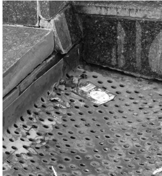
Решітка фонтану «Каскад» дещо поржавіла та забита сміттям і листям
