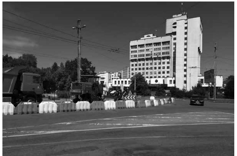
Працює важка ремонтна техніка
