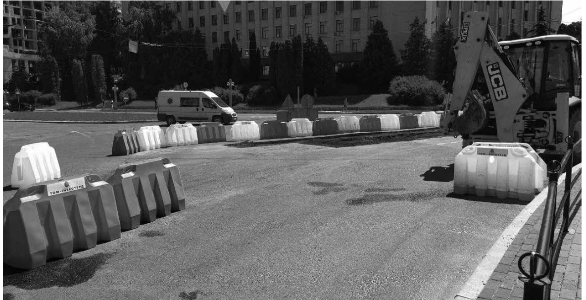
На ділянці біля ОВА вже проводять роботи
