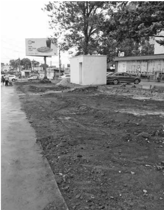
Навколо укриття зняли шар ґрунту
