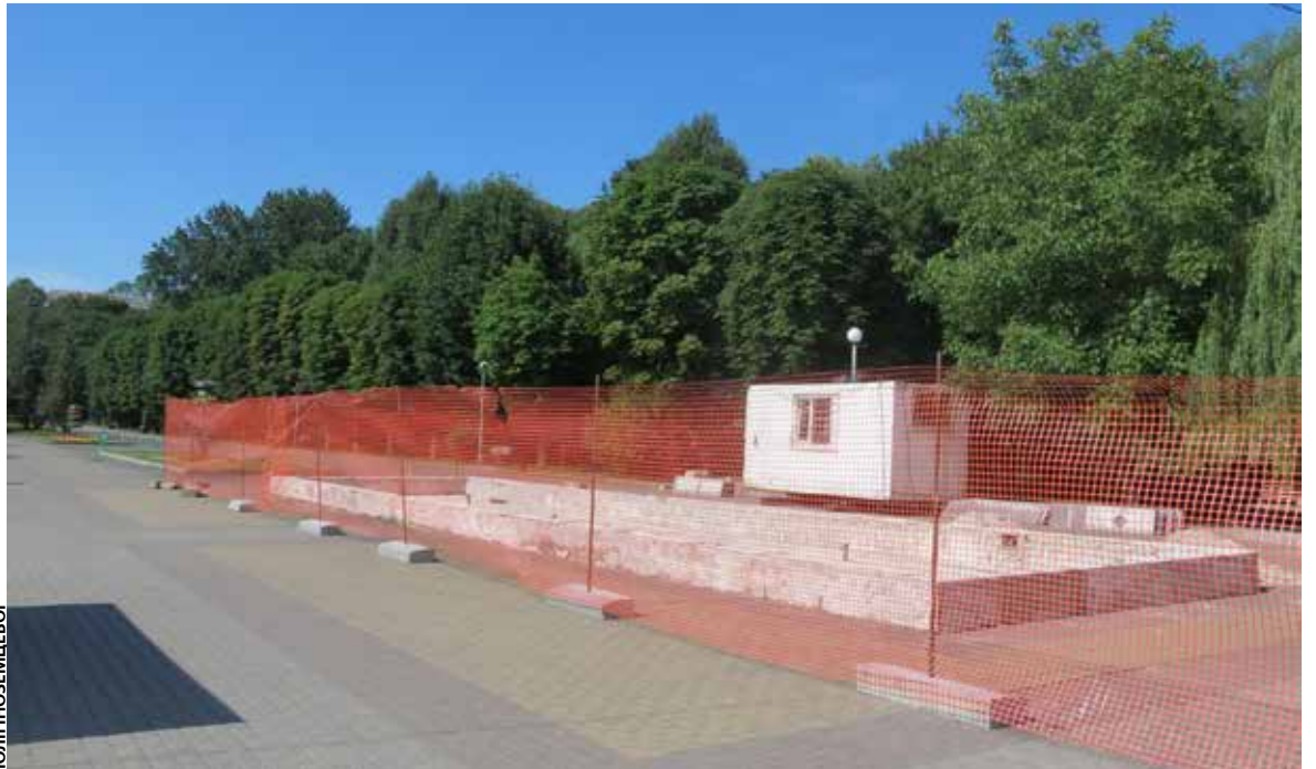
Фонтан був обгороджений, там проводили ремонт
