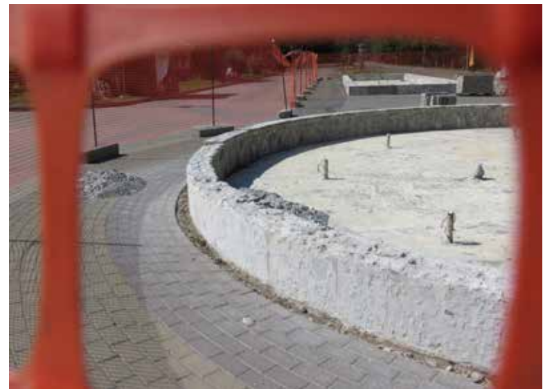
Кам'яну плитку з водограю демонтували
