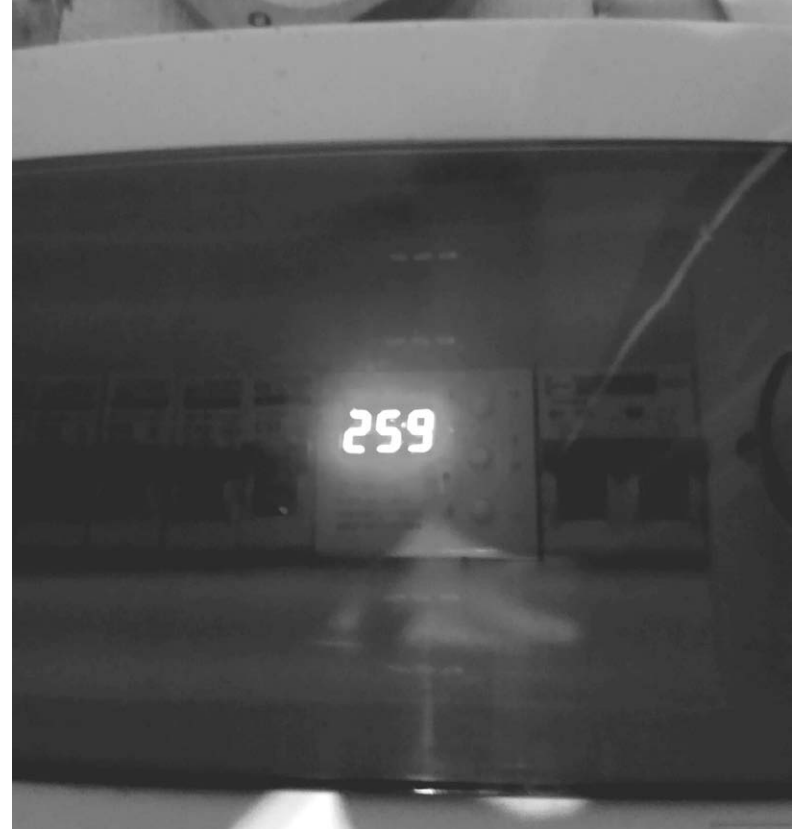
Автомат у квартирі Петра Чорного зафіксував 259 вольт, при дозволених 220. Електроенергії не було більше шести годин
