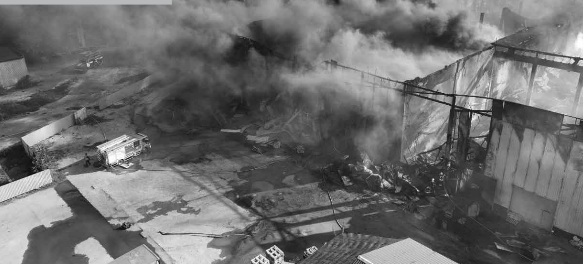
Будівля заводу була заповнена пінопластом. Дим з пожежі ширився на кілька мікрорайонів міста
