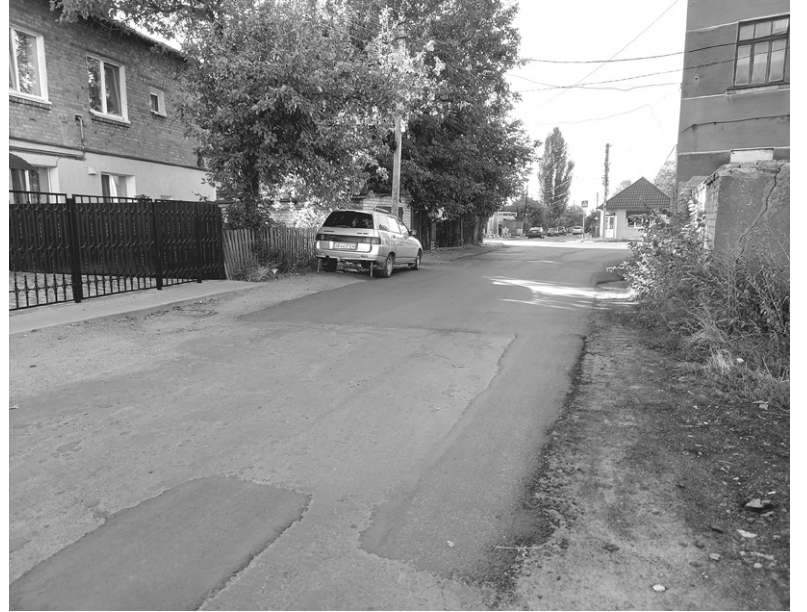
На початку цього місяця дорожники ремонтували не лише центральну вулицю. На вулиці Чумацький Шлях (колишня Мічуріна) теж з'явилися нові латки
