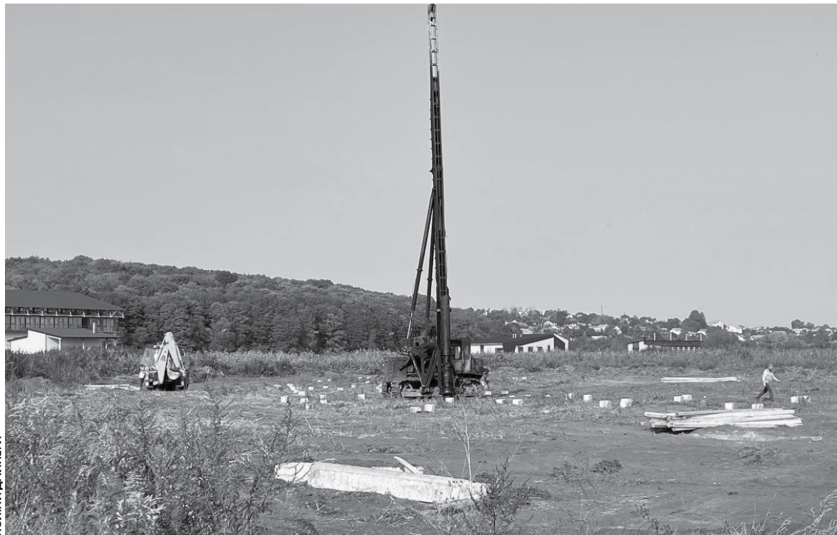
За допомогою спецтехніки будівельники проводять підготовчі роботи для фундаменту
