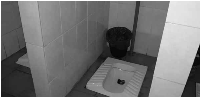
Туалет у парку розташований у підземних приміщеннях. Між кабінками є лише перегородки
