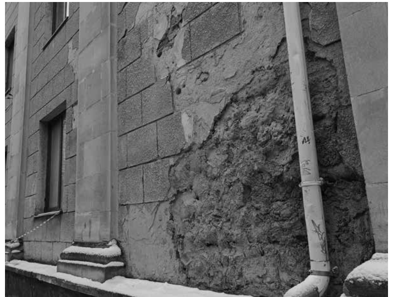
У листопаді, за нашим спостереженням, місце, де цегла посипалась найбільше, зашпаклювали
