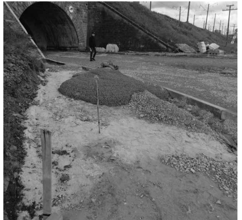
Роботи з ремонту Гайової ще тривають
