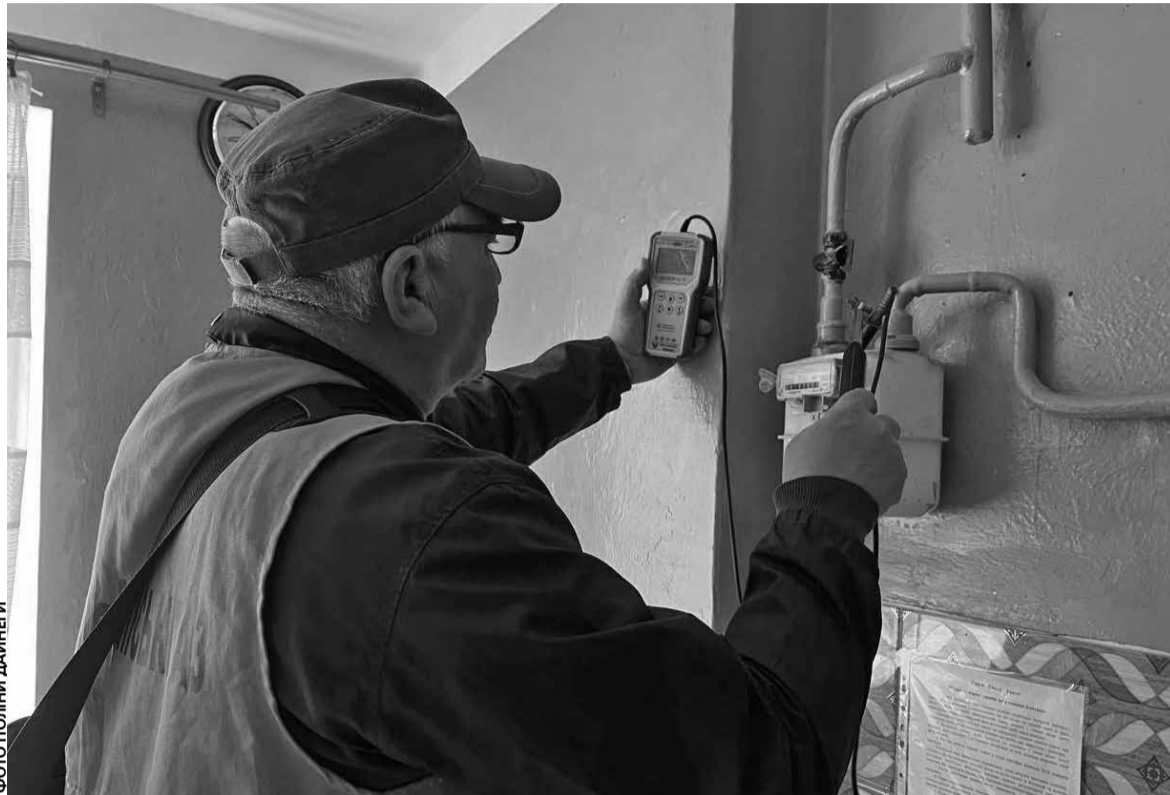
Зі спецобладнанням газовики перевіряють кожен кран та труби
