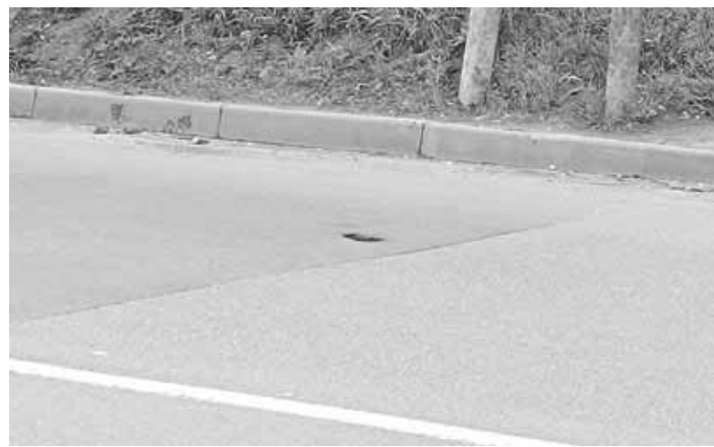
Покриття у деяких місцях вже почало псуватися. Хоча гарантія на нього три роки
