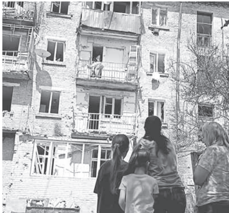
Від прильоту «Шахеда» в будинках повибивало вікна. На щастя, ніхто не загинув, лише кілька людей отримали поранення від розбитого скла
